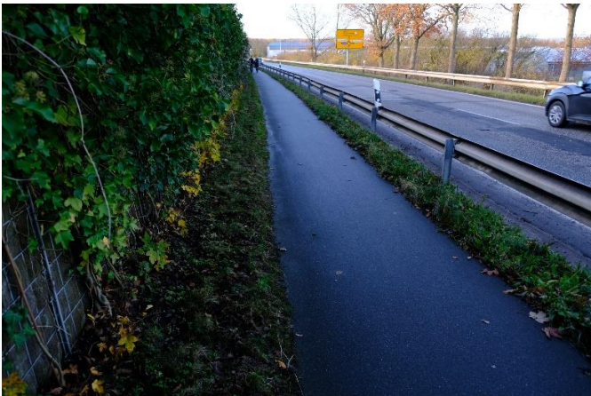
Foto 1: Radweg Erdbeerfeld Richtung B503.
