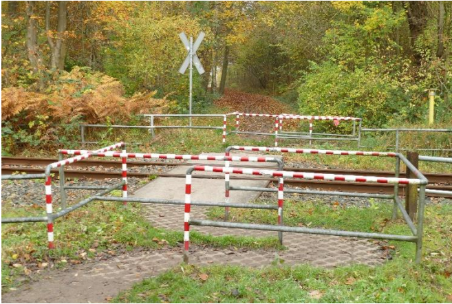
Foto 6: Bahnübergang auf Höhe der B503.
